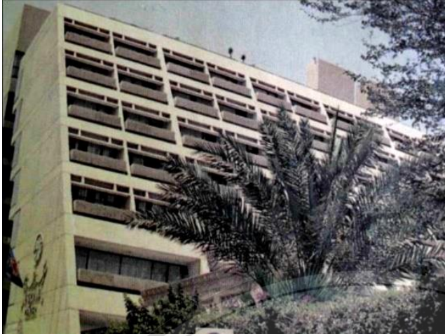
شكل (٤٩) استخدام الكاسرات الأفقية في واجهات المباني
