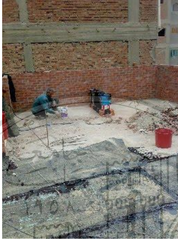
شكل (٢٩) استخدام اللفات الاسفلتية في العزل
